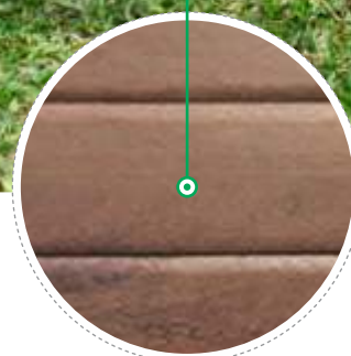
Acabamento das réguas
