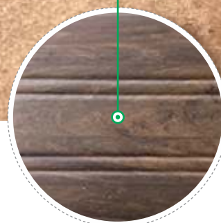
Acabamento das réguas
